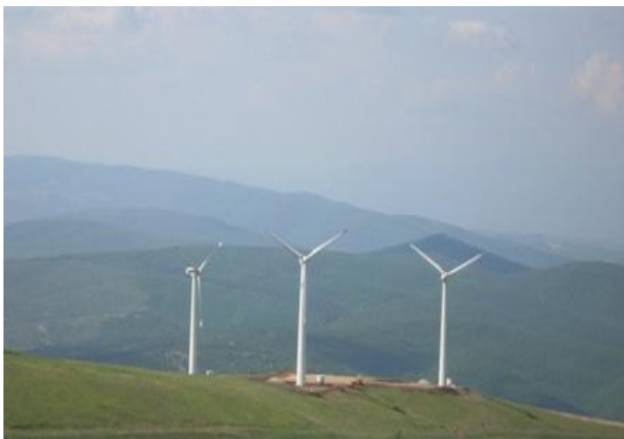
Fig.3.1. Kapacitet i ri energjetik nga era, 3 x 450 kw, Golesh.
